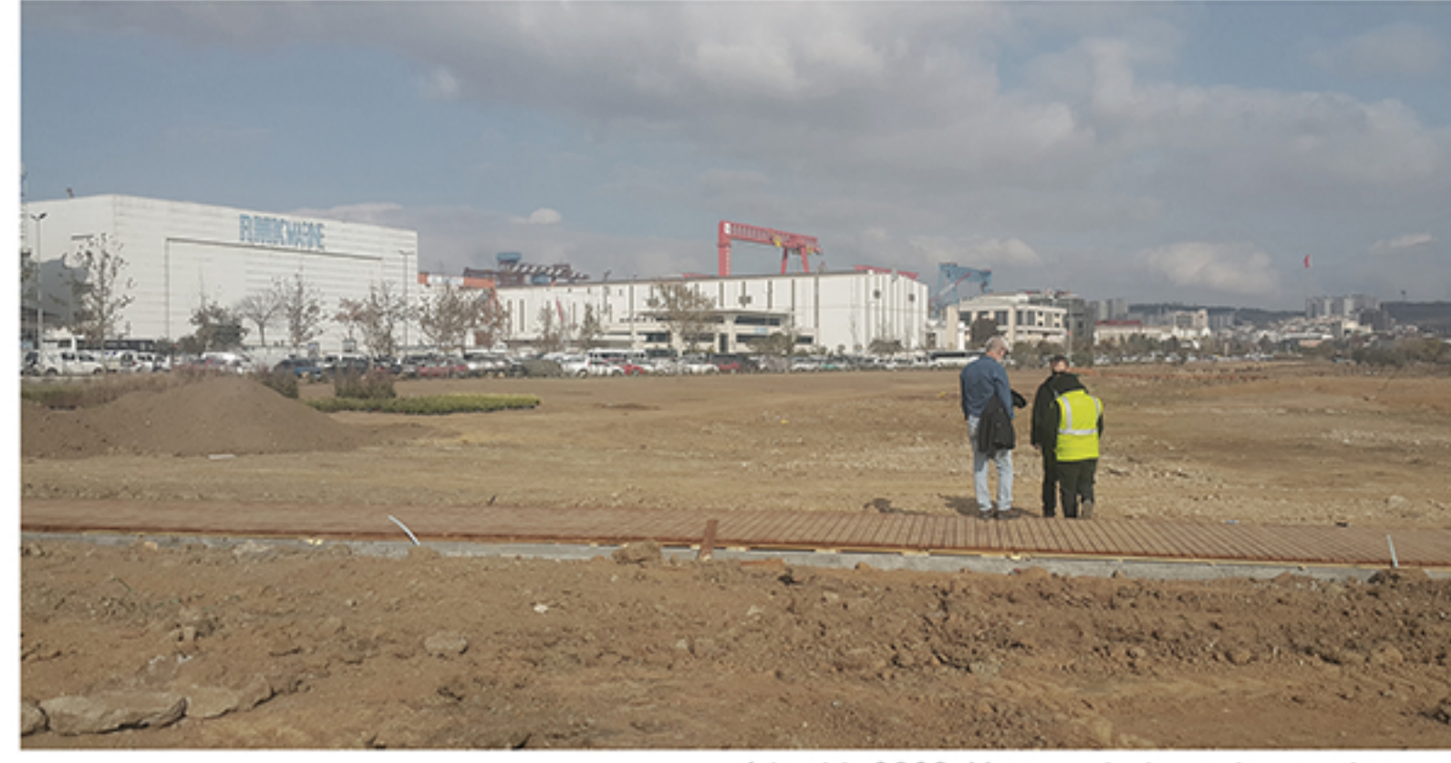
6 Aralık 2020. Yağmur bahçesi konstrüksiyonu
