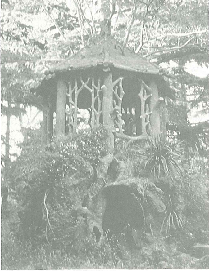
Rustik kamerya ve grottonun yıkılmadan önceki hali
