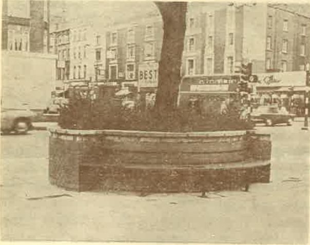
Şekil : 6. Kent içi yol ağaçlarını, araçlardan ve kışın dona karşı kullanılan tuzun yaratacağı olumsuz etkilerden korumak için dikim yerlerini zeminden yükseltmek gerekebilir. Şekilde böyle bir önlemin, oturma işleviyle birlikte düzenlenmiş olduğu görülmektedir. (Orijinal, Londra)
