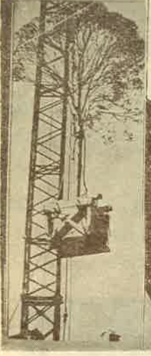
Şekil : 14. Ambalajlanmış ağaçların bazen binaların çatılarında planlanan «ÇATI BAHÇELERİ — Roof Garden»nde kullanılması gerektiğinde vinç kullanılır.
