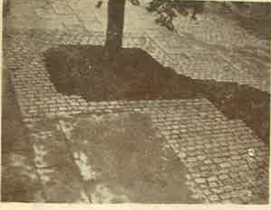
Şekil : 2. Sert döşemeli bir yere dikilen ağacın normal gelişebilmesi için zeminde bırakılması gereken toprak alan kenarları 2-2.5 m olan bir dörtgen olmalıdır. Bu alan geometrik (formal) biçimde olabildiği gibi, doğal (informal) biçimde de olabilir. (Orijinal, Karlsruhe)
