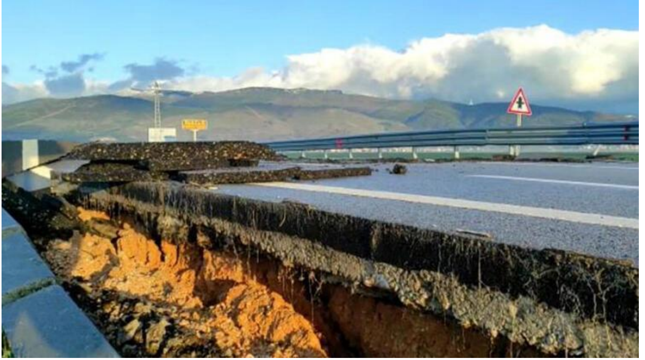
Şekil 6: Hatay Havaalanı Pist Yolu - 1
