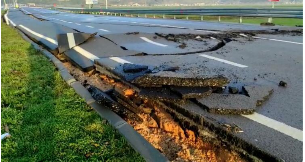
Şekil 7: Hatay Havaalanı Pist Yolu – 2
